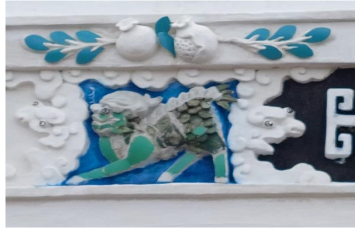
施工說明：(修復後)
