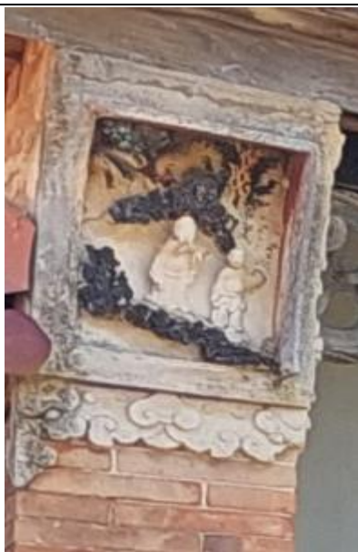
施工說明：墀頭右 (修復前)
