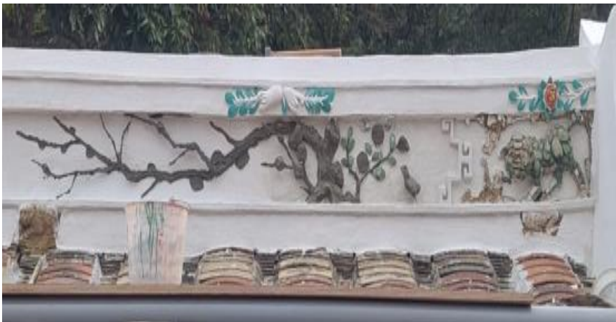
施工說明：花堵(修復中) 位置：中脊左
