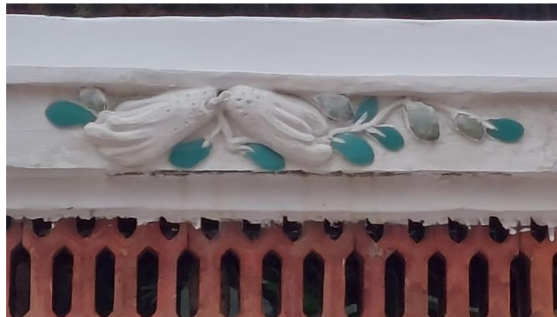
施工說明：(修復後)
