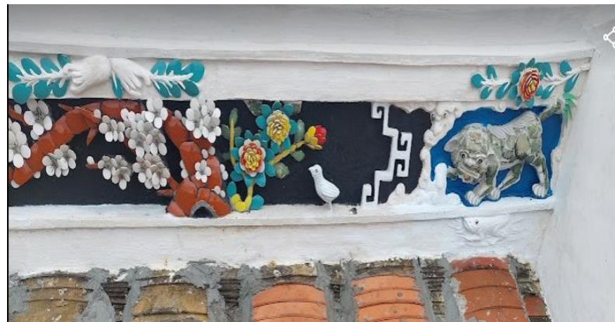
施工說明：(修復後)
