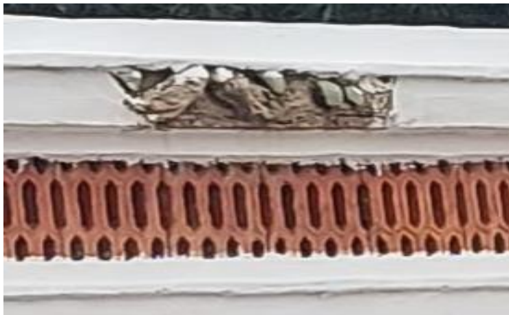
施工說明：佛手(修復前) 位置：中脊中右
