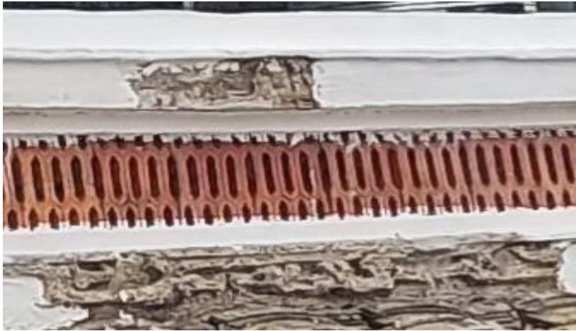
施工說明：如意 (修復前) 位置：中脊中
