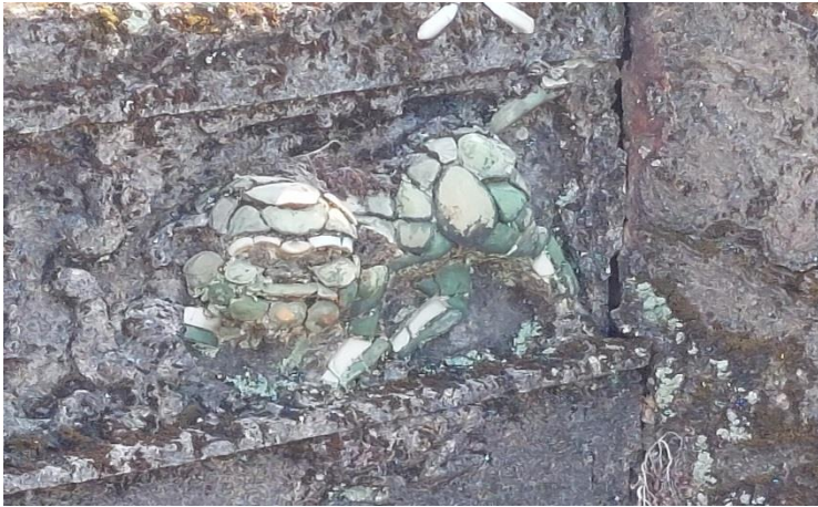
施工說明：獅 (修復前) 位置：中脊左
