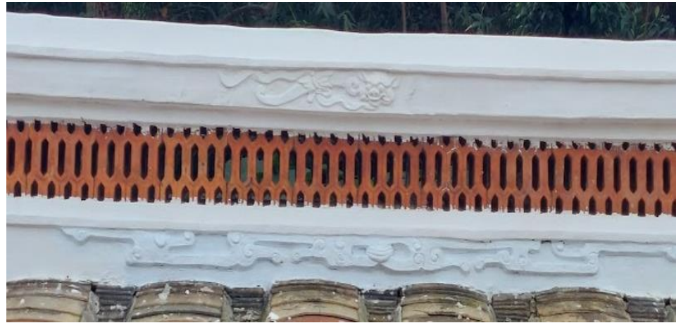
施工說明：(修復後)
