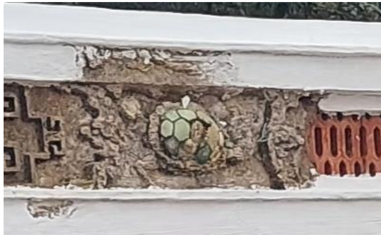
施工說明：龜(修復前) 位置：中脊右中
