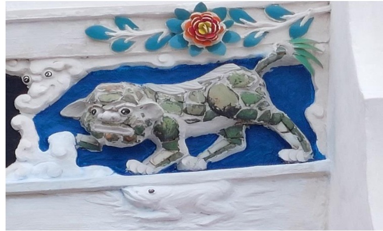
施工說明：(修復後)
