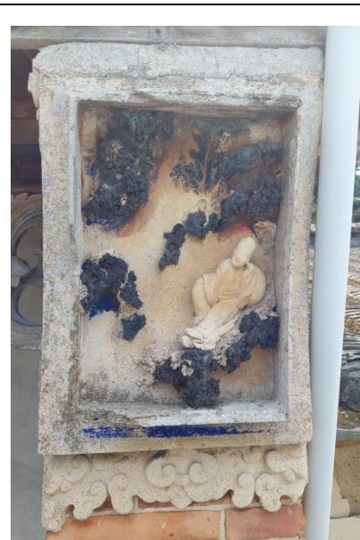
施工說明：墀頭左 (修復前)
