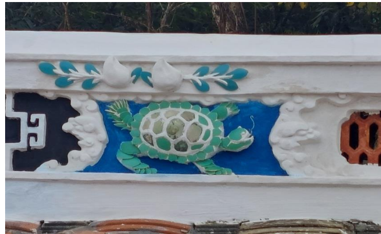
施工說明：(修復後)
