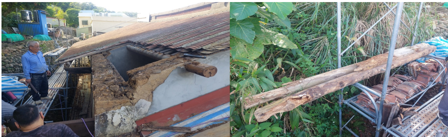
施工說明：木構件落架 位置：正廳右後坡
