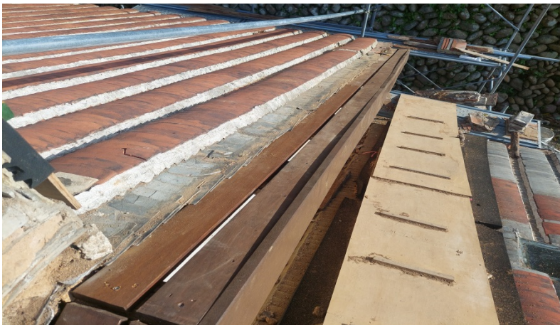
施工說明：桷木板抽換 施工說明：桷木板抽換 位置：正廳左規帶 位置：正廳右規帶
