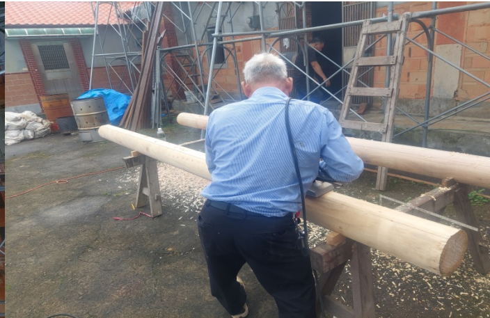
施工說明：圓桁水面加工
