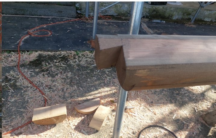
施工說明：雀尾加工及護木漆
