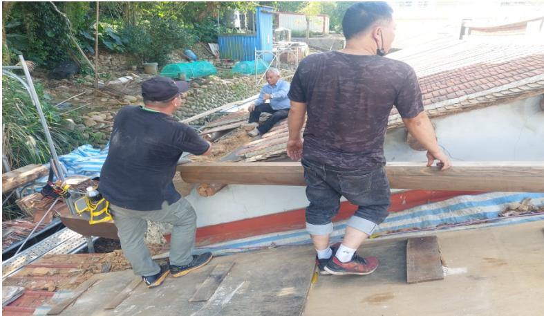
施工說明：圓桁上架 施工說明：桷木板鋪設 位置：正廳右後坡
