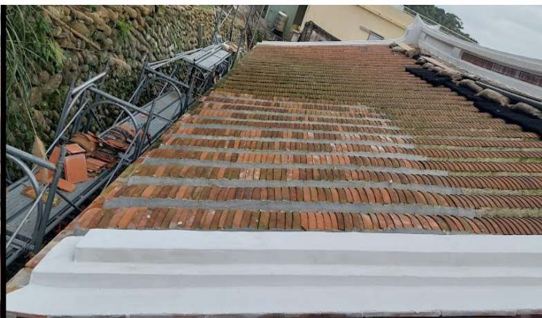
施工說明：屋瓦鋪設 位置：正廳 後坡
