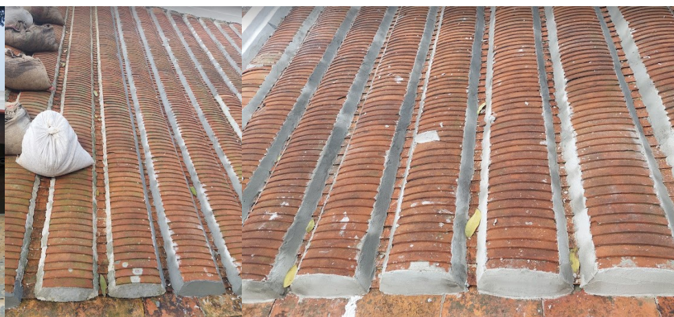
施工說明：屋瓦槽重新粉刷 位置：正廳 前後坡
