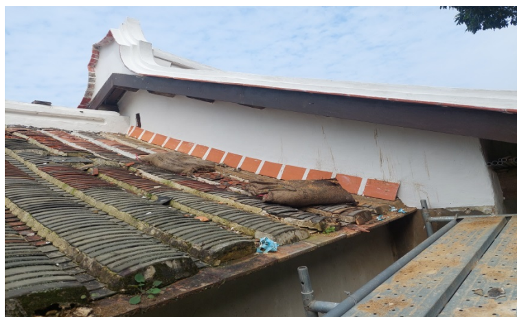
施工說明：馬背、規帶新做 位置：正廳 左後坡
