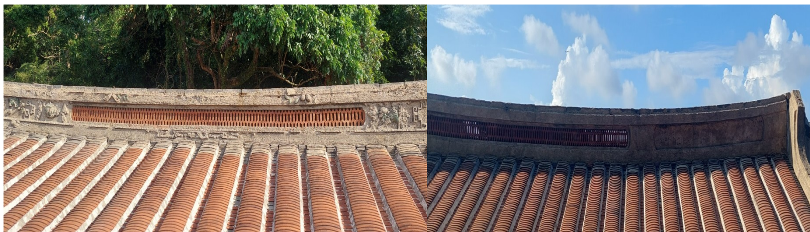
施工說明：白灰粉刷風化 位置：正廳正脊前
