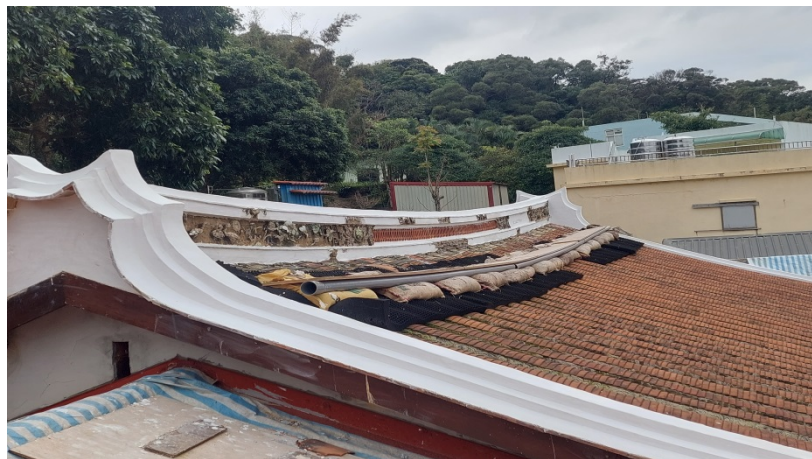
施工說明：中脊白灰修復 位置：正廳
