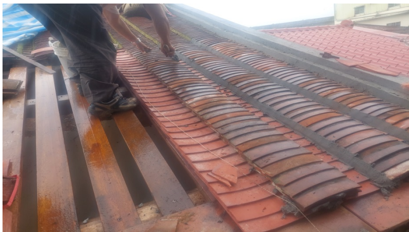
施工說明：屋瓦鋪設 位置：正廳 後坡
